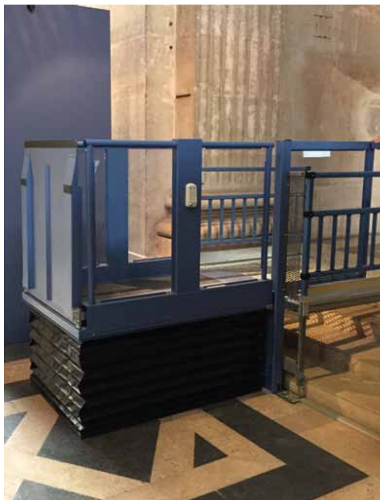
Rampe d'accès crée une barrière alignée avec les parois latérales
